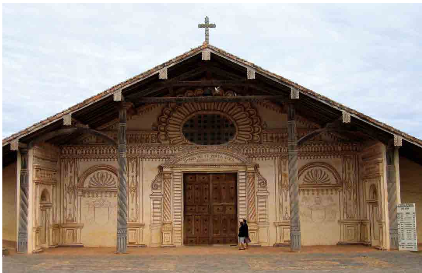
Fig. 1 El pórtico de la iglesia de San Javier de Chiquitos , obra de Martin Schmid, 1749-52, con la inscripción "Casa de Dios y puerta del cielo" en latín encima del portal. Foto: Eckart Kühne, 2004.
